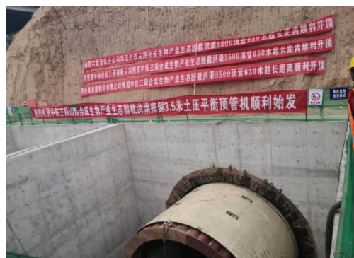
DN3500 土压平衡顶管
