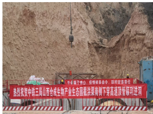
DN3500 泥水平衡顶管
