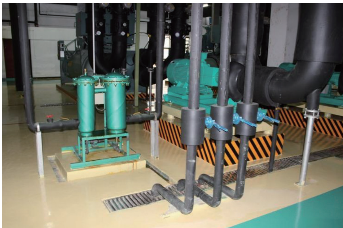
图1：暖通空调施工现场图
