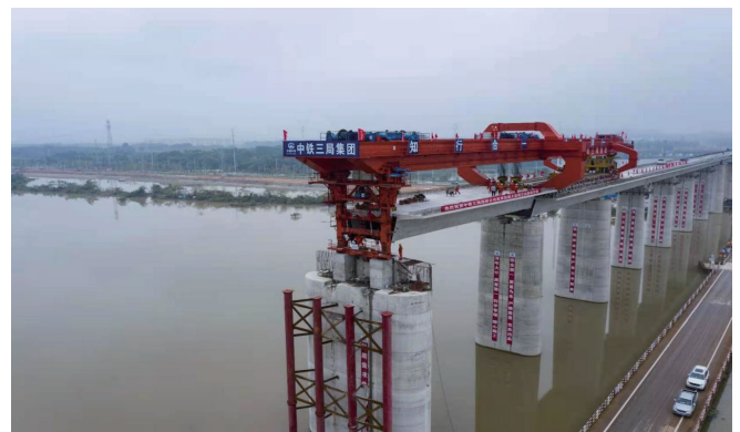
图4 施工完成的临时支墩及简支箱梁架设
